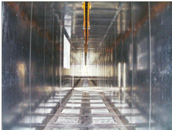
Vista interior horno de secado de pinturas
